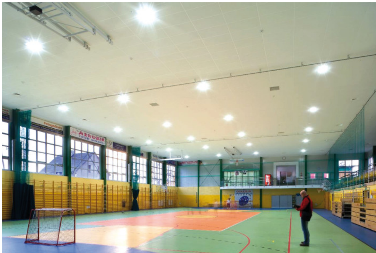
Sala sportowa przy SP nr 3 w Gogolinie. Dźwiękochłonny sufit podwieszany na całej powierzchni sali. Dźwiękochłonne panele ściennie instalowane na ścianie szczytowej na poziomie I piętra (szare pola). Fot.: Szymon Polański
