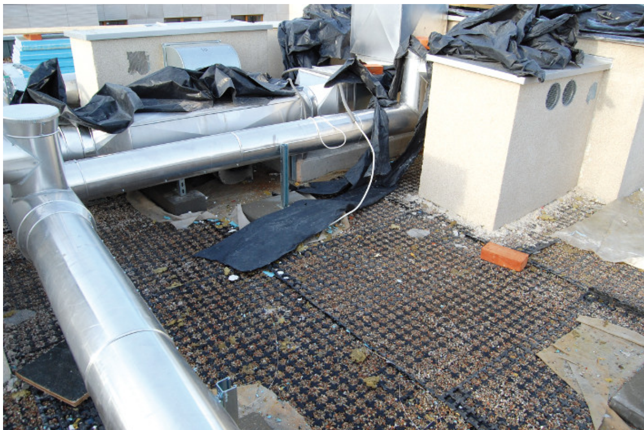
Fot. 4. Wykonanie dachu zielonego oraz innych robót budowlanych i instalacyjnych
