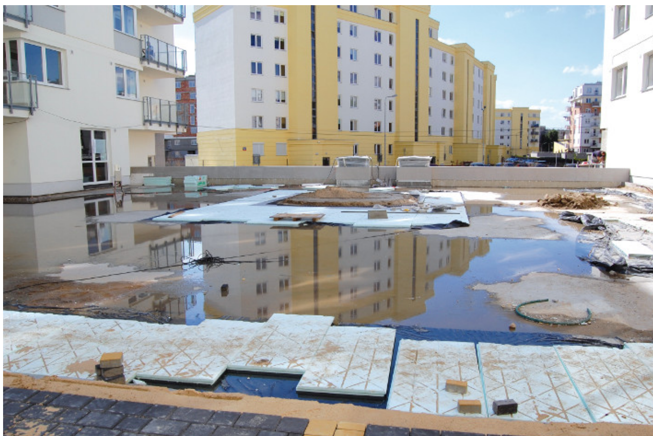
Fot. 5. Przygotowanie do układania termoizolacji
