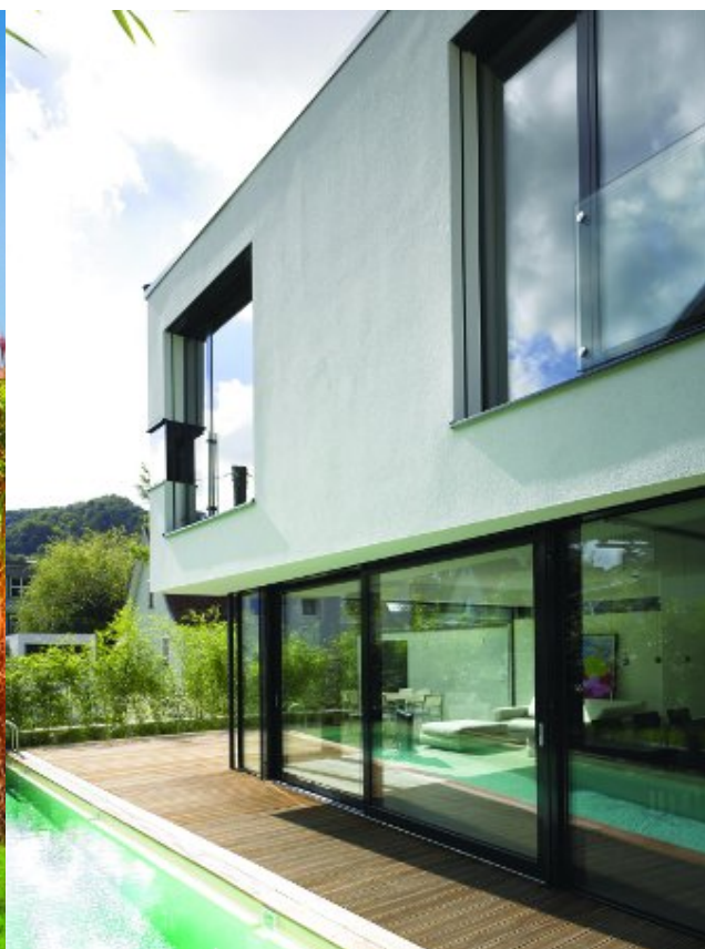
Fot. 2. Budynek z oszkleniem na elewacji południowej
