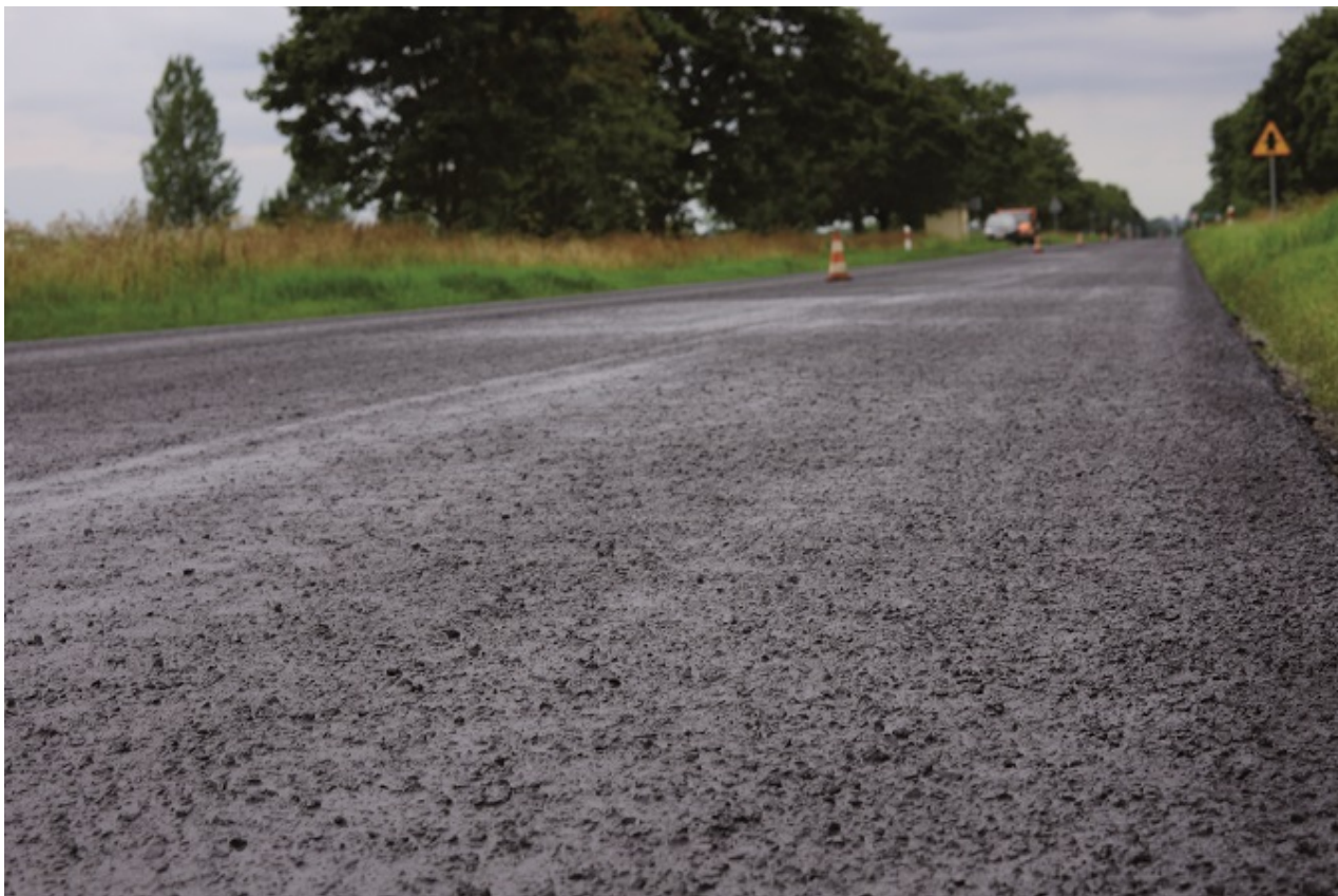
Fot. 1. Warstwa „slurry seal” (fot. Paweł Tofliński)
