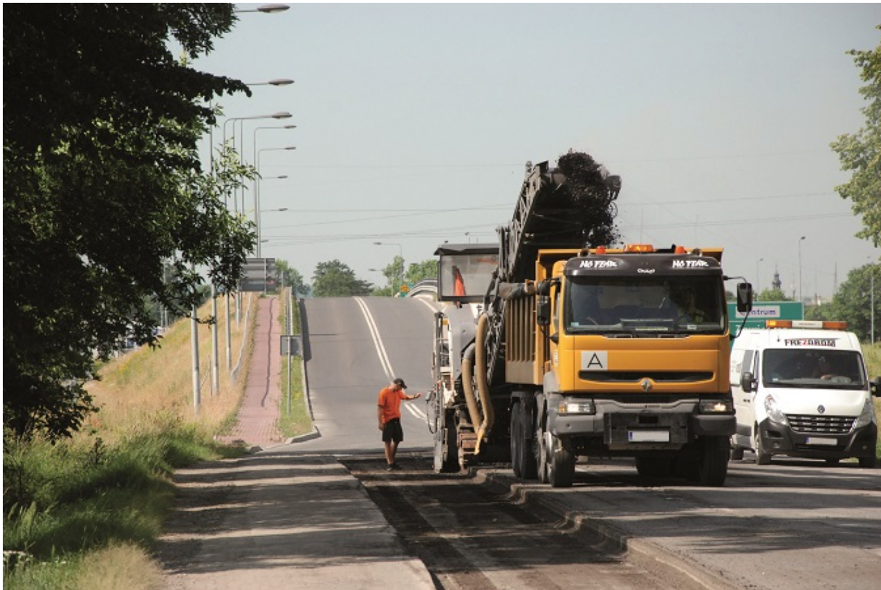
Fot. 2. Frezowanie warstw asfaltowych (fot. Andrzej Szyller)
