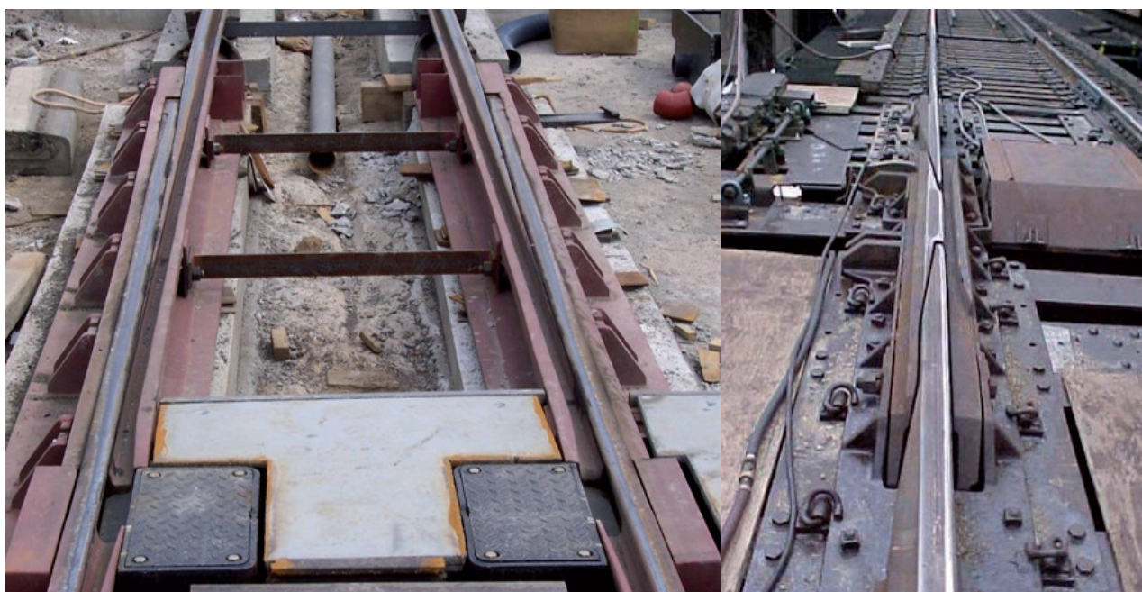
Fot. 3. Przyrząd wyrównawczy z ciągłą krawędzią toczną: a) pojedynczy
