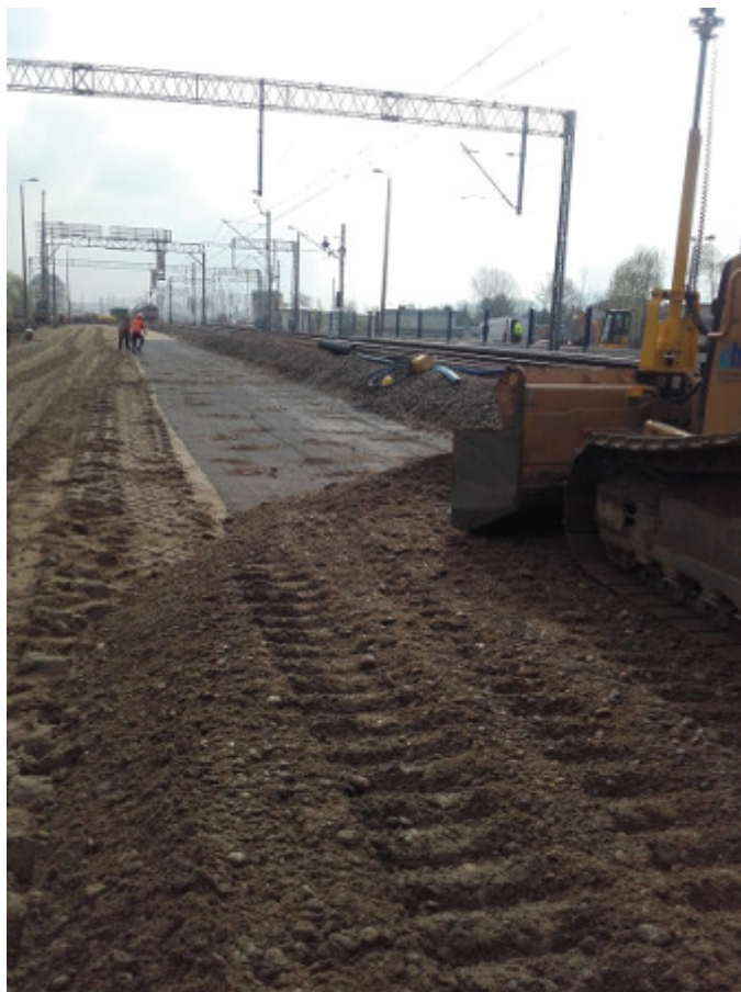
Fot. 4. Układanie geosyntetyków w podtorzu
