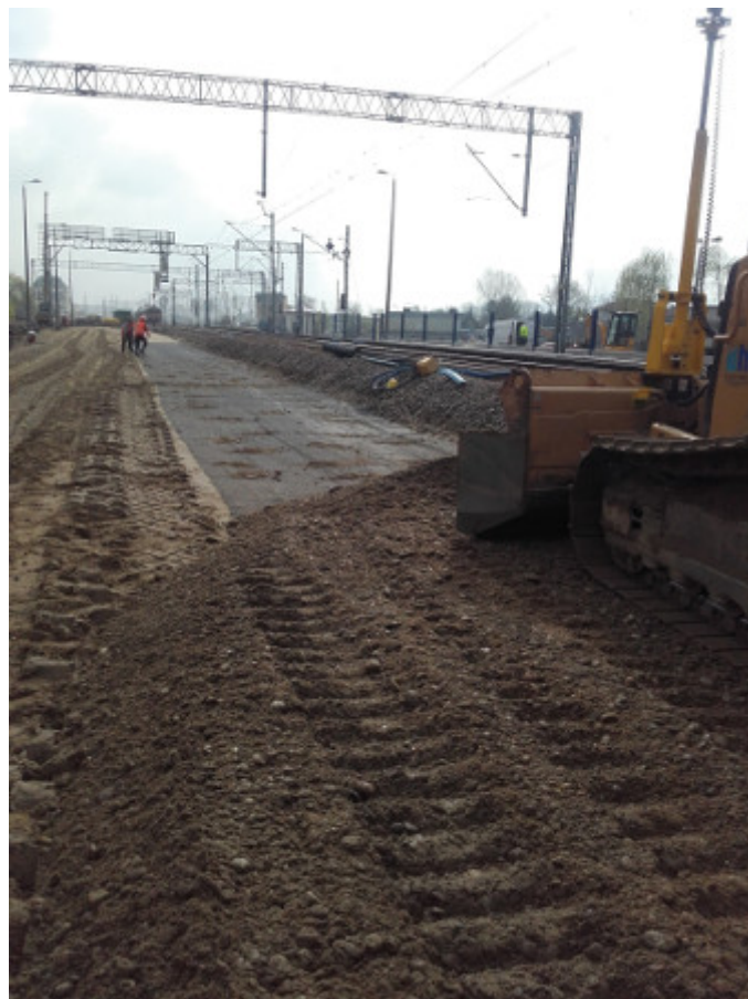
Fot. 4. Układanie geosyntetyków w podtorzu
