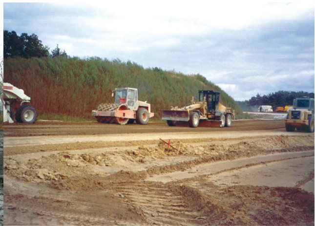
Fot. 6. Drogowe roboty ziemne
