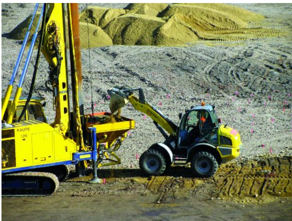
Fot. 7. Kosz zasypowy do napełniania wibratora śluzowego
