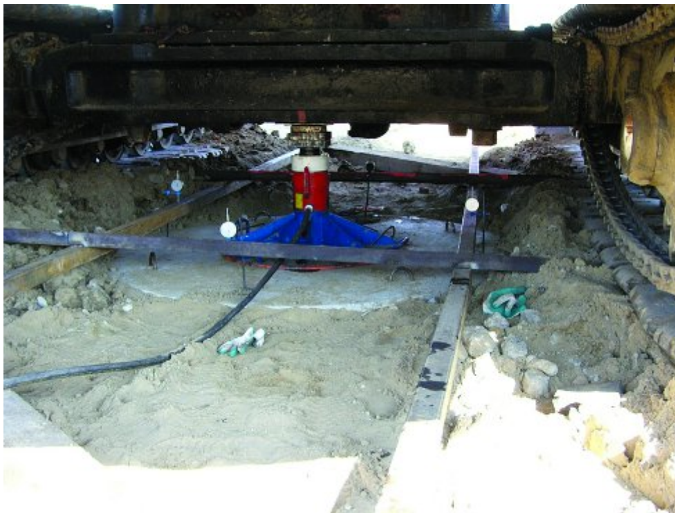
Fot. 5. Próbné obciążenie płytą statyczną z wykorzystaniem dźwigu używanego do wykonania kolumn
