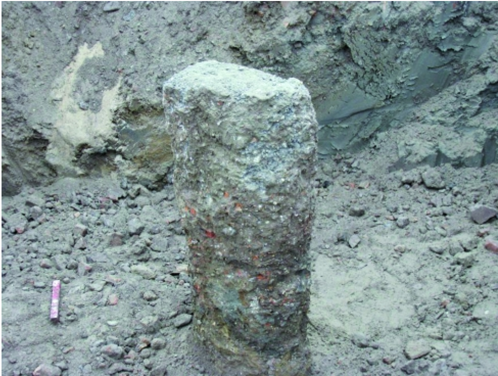
Fot. 8. Głowica kolumny wibrocementowej wykonana w gruntach organicznych i nasypowych
