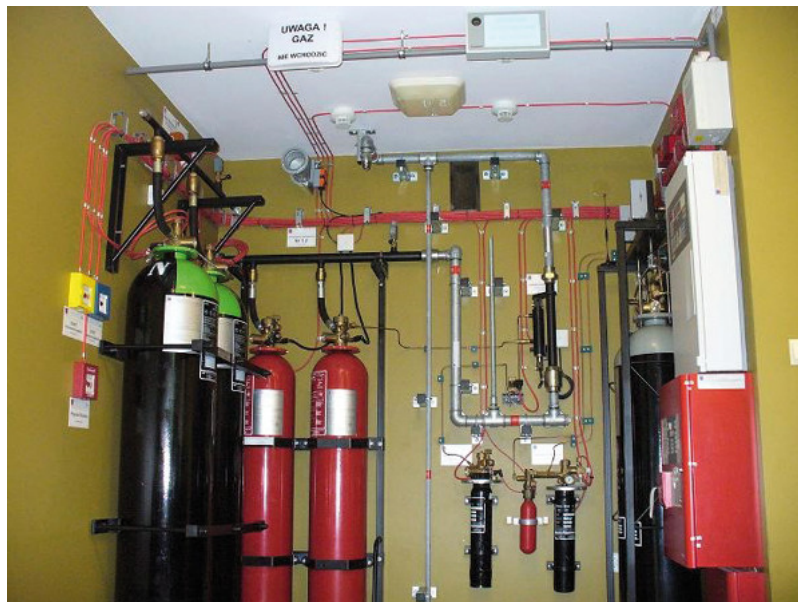
Fot. 5. Przykładowa instalacja SUG gazowych, wykorzystywana do celów szkoleniowych. Źródło: archiwum CNBOP-PIB
