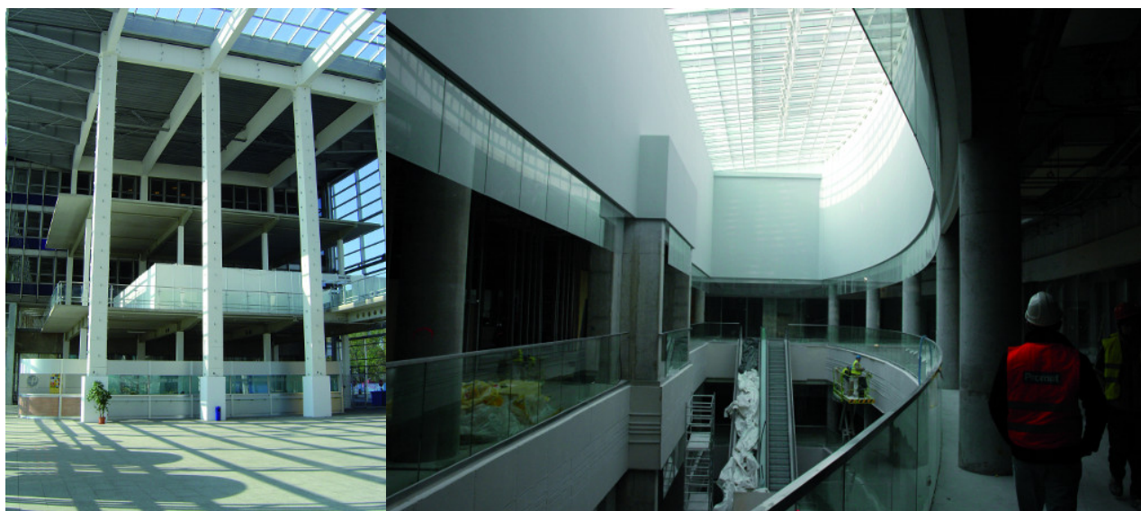
Fot. 9. Zabezpieczenie płytami ogniochronnymi stalowej konstrukcji nośnej – hol główny MTP w Poznaniu. Autor: archiwum ITB
