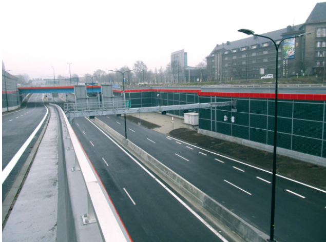
Fot. 10. Ściany oporowe dojazdu do tunelu wykonane w technologii ścian szczelinowych
