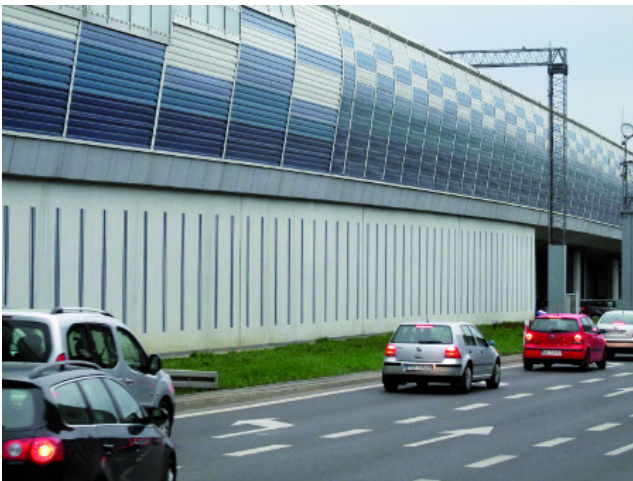
Fot. 1. Ściana żelbetowa dojazdu do Wiaduktu
