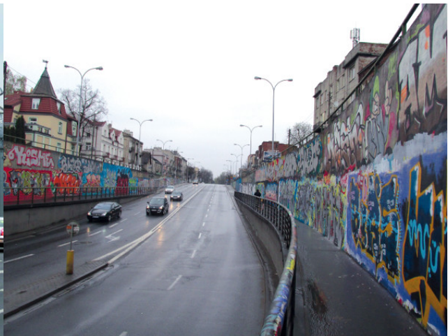
Fot. 2. Ściana oporowa przejazdu pod torami kolejowymi
