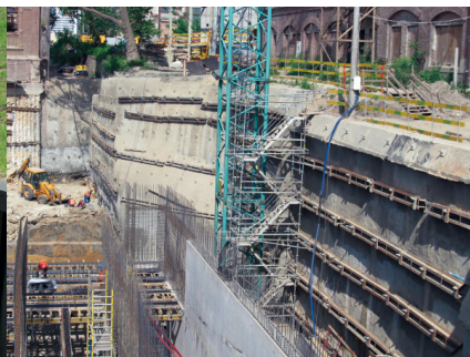
Fot. 13. Torkretowana ściana gwoździowana głębokiego wykopu
