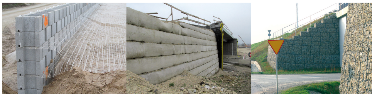
Fot. 7. Ściana oporowa z drobnowymiarowych elementów betonowych z gruntem zbrojonym siatkami geosyntetycznymi
