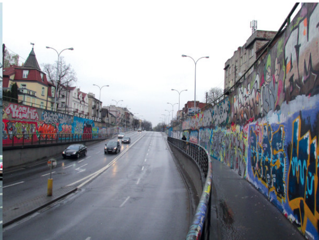
Fot. 2. Ściana oporowa przejazdu pod torami kolejowymi
