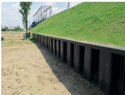
Fot. 12. Przykład ścianki oporowej z grodzic z tworzyw sztucznych
