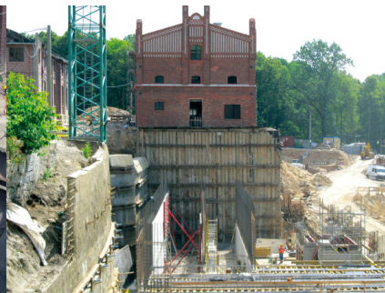
Fot. 14. Palisada stanowiąca obudowę głębokiego wykopu
