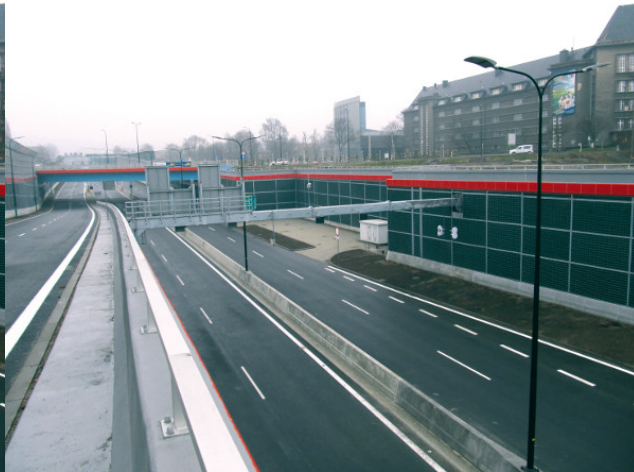
Fot. 11. Ściany oporowe i przyczółek wykonany z grodzic stalowych
