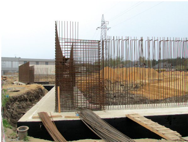
Fot. 3. Widok zbrojenia pionowego ściany żelbetowej
