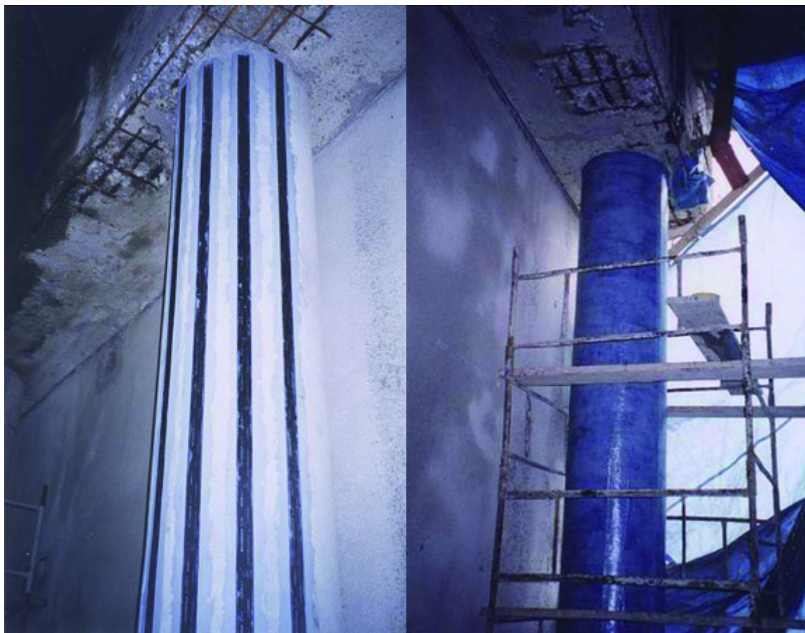
Fot. 2. Wzmocnienie taśmami i matami CFRP słupa filara wiaduktu w Rzeszowie: wzmocnienie taśmami (po lewej), wzmocnienie matami (po prawej)
