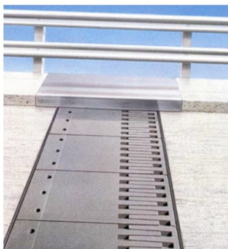
Rys. 6. Palczaste urządzenie dylatacyjne odmiany drugiej („belkowej”)
