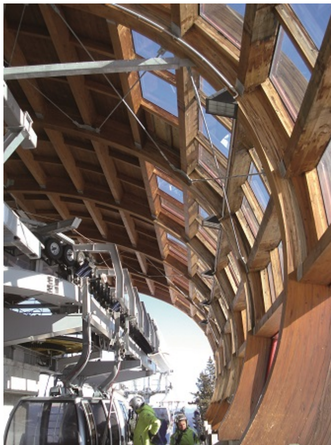
Fot. 11. Przekrycie w łuku nad stacją kolejki górskiej (Pejo - Włochy) (źródło autora)
