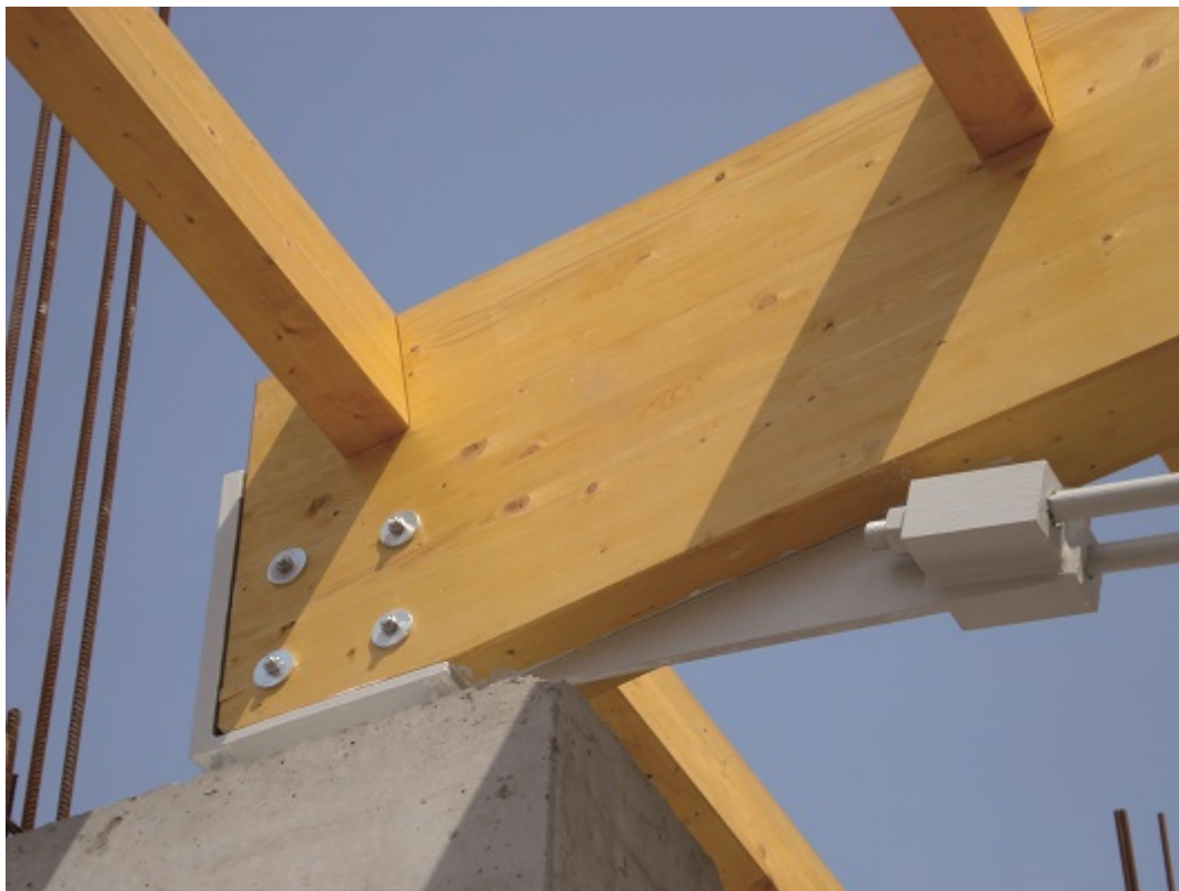
Fot. 9. Węzeł podporowy z łącznikami sworzniovymi (przekrycie basenu AGH w Krakowie) (źródło autora)
