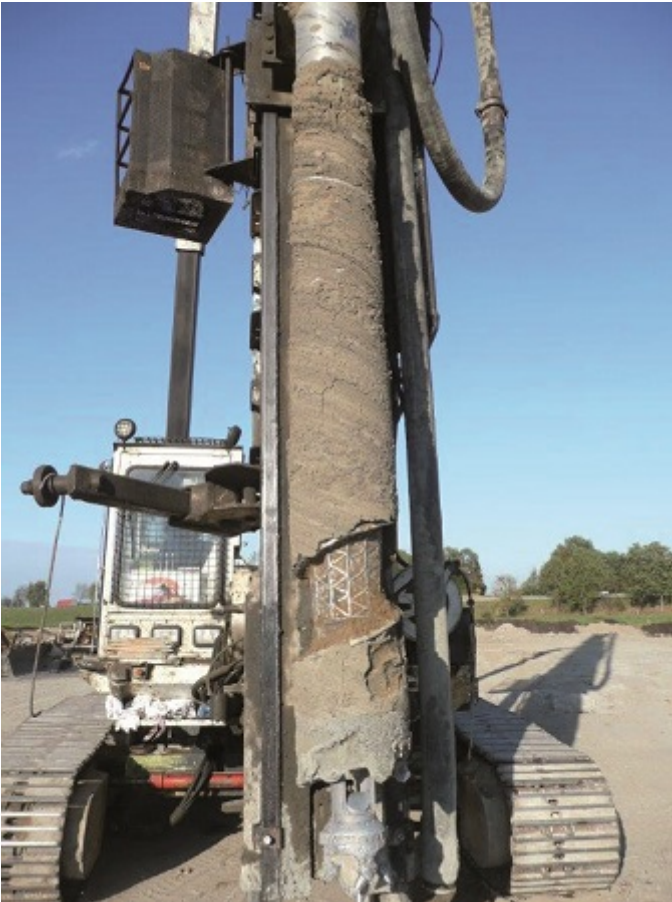
Fot. 3. Formowanie kolumn przemieszczeniowych
