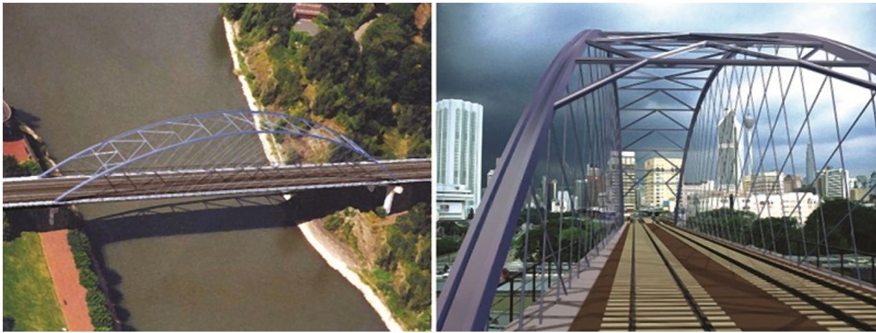
Fot. 9. Łukowy most kolejowych typu „network arch” [2]
