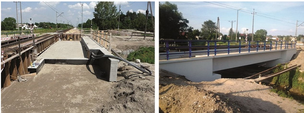
Fot. 3. Przebudowa małego mostu stalowego z wykorzystaniem nowego przęsła z dźwigarów obetonowanych
