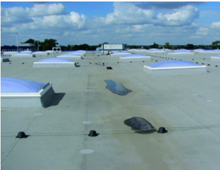
Fot. 1. Widok stropodachu pełnego krytego folią PVC (fot. Z. Matkowski)
