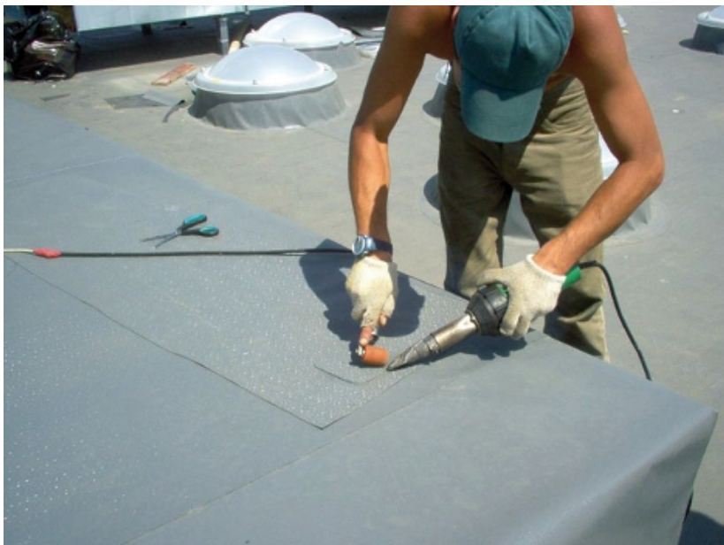
Fot. 5. Zgrzewanie folii PVC gorącym powietrzem (fot. Z. Matkowski)
