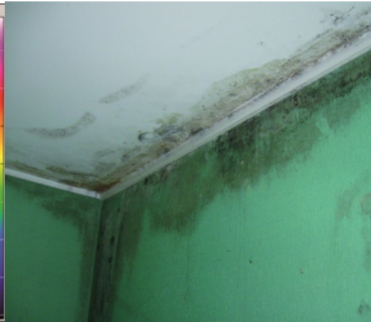
Fot. 2. Zjawisko obniżonej temperatury na wewnętrznej powierzchni przegrody – ryzyko rozwoju pleśni i grzybów pleśniowych
