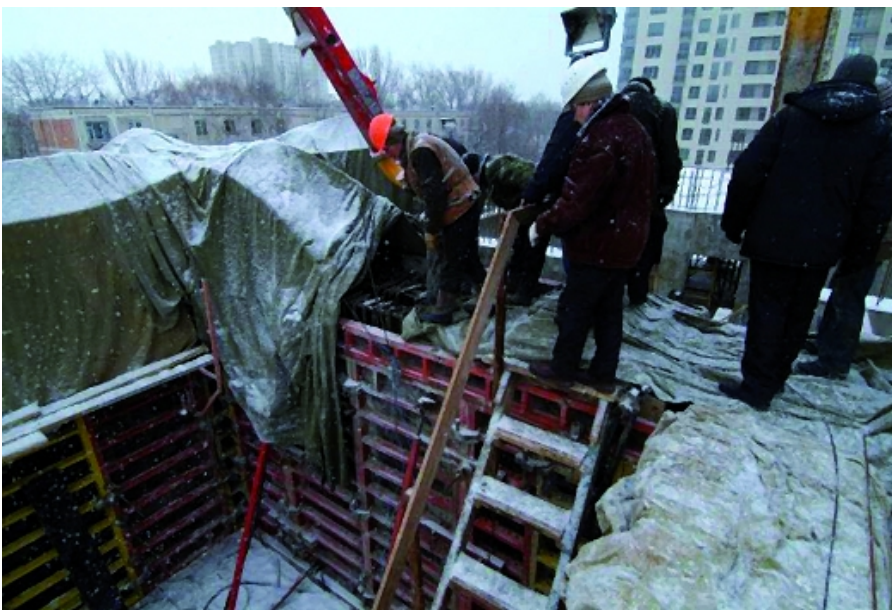
Fot. 1. Betonowanie w warunkach zimowych
