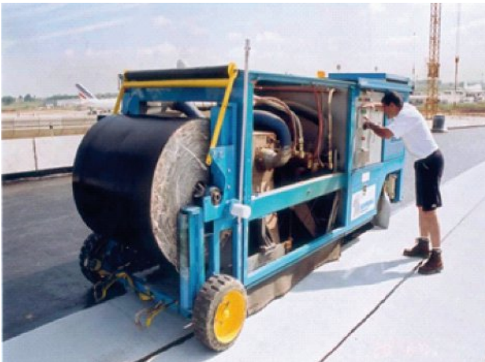
Fot. 3. Automatyczny proces aplikacji papy do podłoża, ogrzewanej gorącym powietrzem
