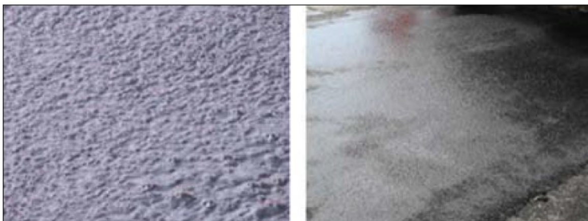
Fot. 6. Wyciskanie mastyksu na etapie wbudowywania mieszanki SMA-MA [6]
