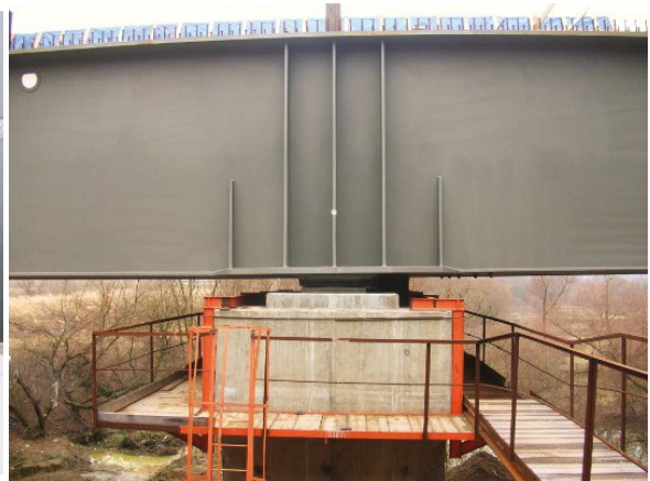
Fot. 3. Ustawienie łożyska garnkowego w czasie budowy obiektu
