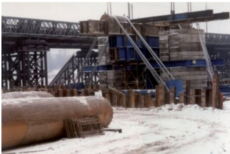
Fot. 1. Konstrukcja jednego z największych w Polsce próbnych obciążeń o sile ok. 14 000 kN na budowie mostu Świętokrzyskiego w Warszawie
