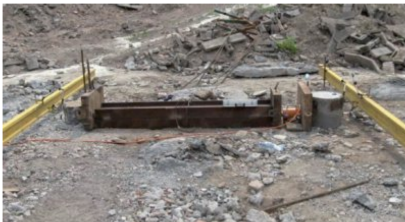
Fot. 6. Przykład badań porównawczych - próbne obciążenia na siły poziome dwóch różnych rodzajów pali
