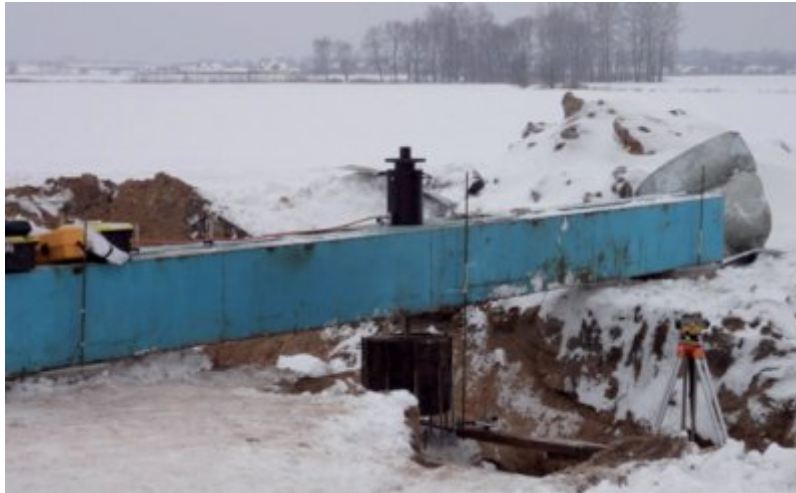
Fot. 4. Stanowisko do próbnego obciążenia pala na wyciąganie
