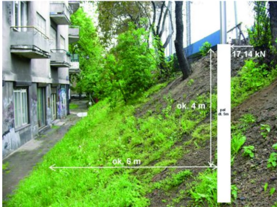
Fot. 5. Przykład próbnego obciążenia na siły poziome pali ekranów akustycznych
