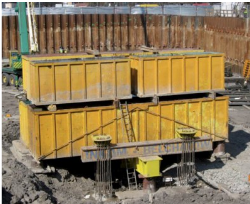
Fot. 2. Konstrukcja z wykorzystaniem zbiorników balastowych
