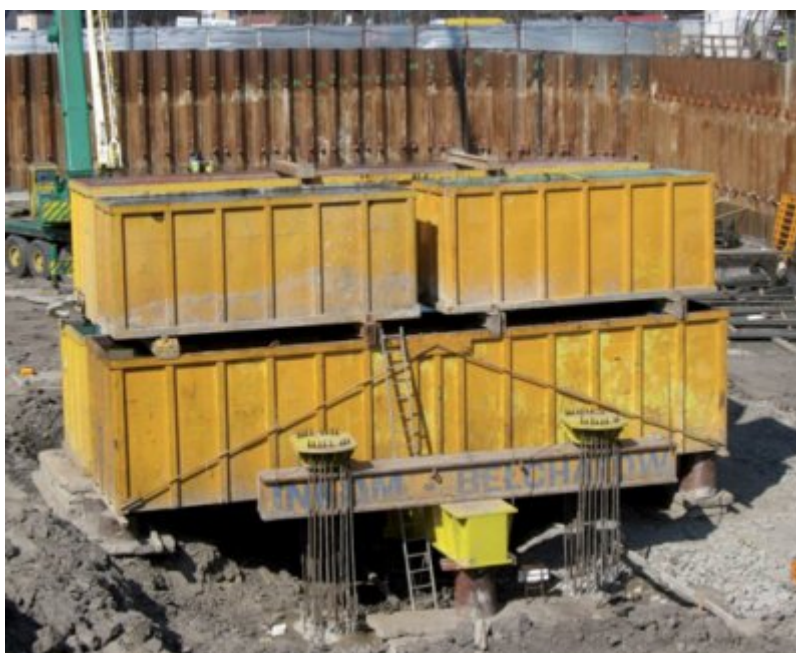
Fot. 2. Konstrukcja z wykorzystaniem zbiorników balastowych
