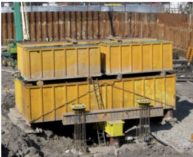
Fot. 2. Konstrukcja z wykorzystaniem zbiorników balastowych
