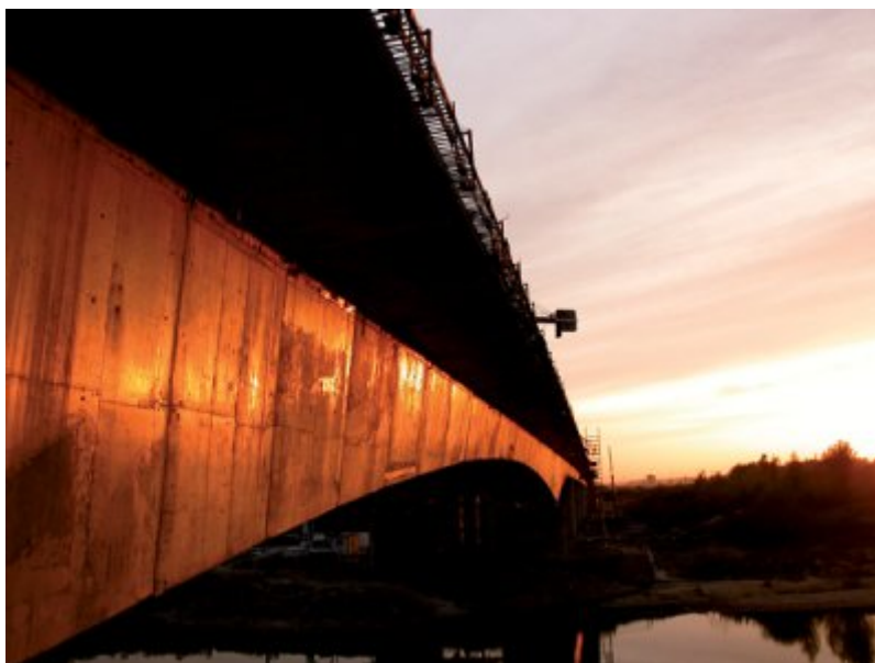
Fot. 3. Przykład konstrukcji budowanej metodą nawisową – most przez rzekę Dunajec w ciągu autostrady A4 (fot. G. Barczyk)
