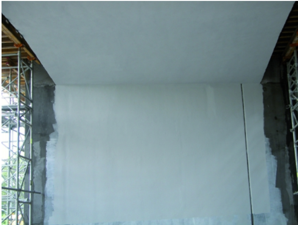
Fot. 2. Powierzchnia betonu z nałożoną warstwą szpachlową i pierwszą warstwą powłoki malarskiej
