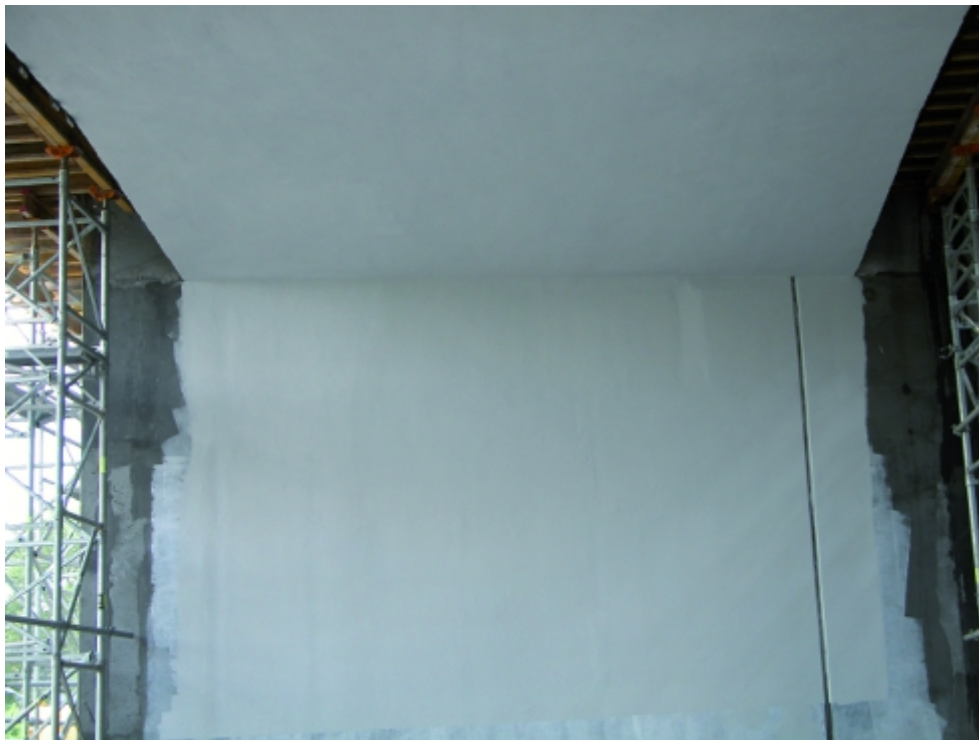
Fot. 2. Powierzchnia betonu z nałożoną warstwą szpachlową i pierwszą warstwą powłoki malarskiej
