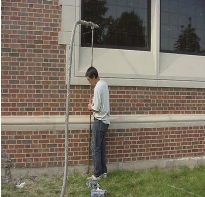
Fot. 5. Izolacja kurtynowa
