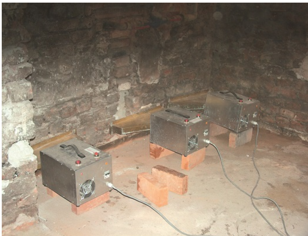
Podgrzewanie strefy iniekcji za pomocą mikrofal – fot. C. Magott
