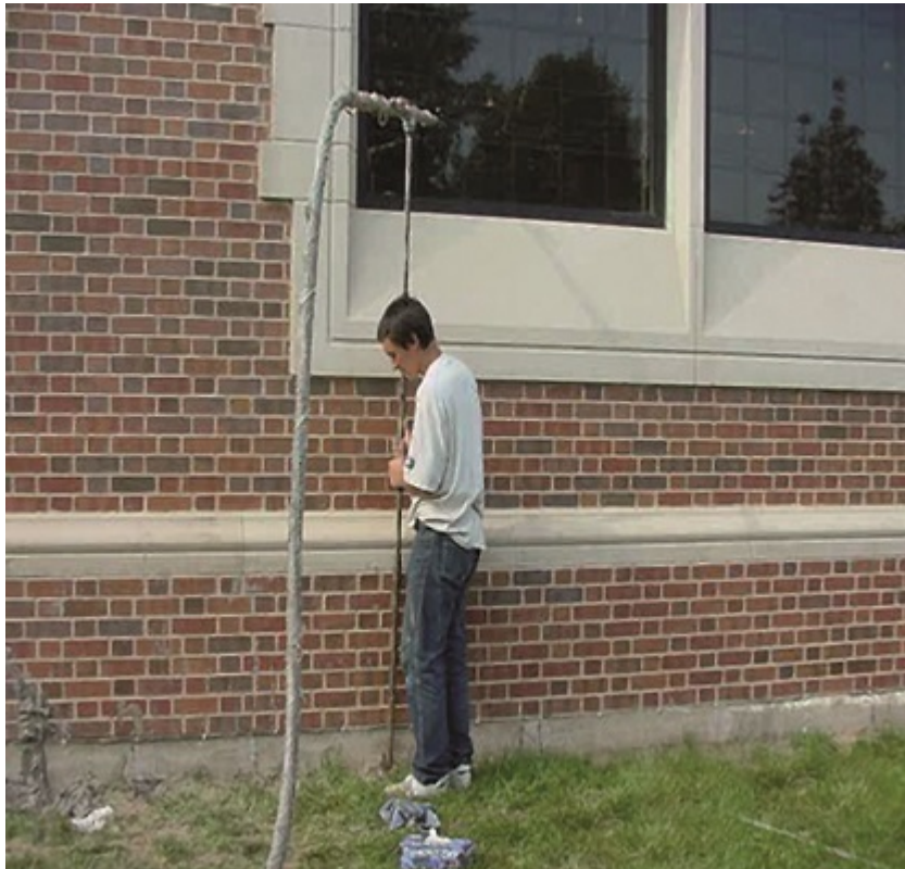
Fot. 5. Izolacja kurtynowa
