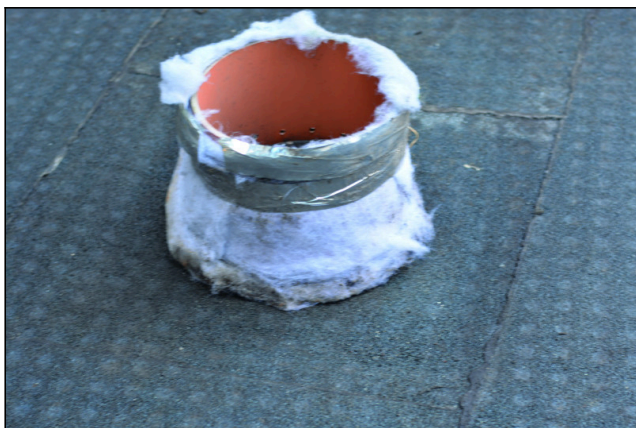
Fot. 4. Skrzynka kontrolna bez pierścienia odciążającego ustawiona bezpośrednio na papierze, bez perforacji, owinięta włókniną (fot. autora)
