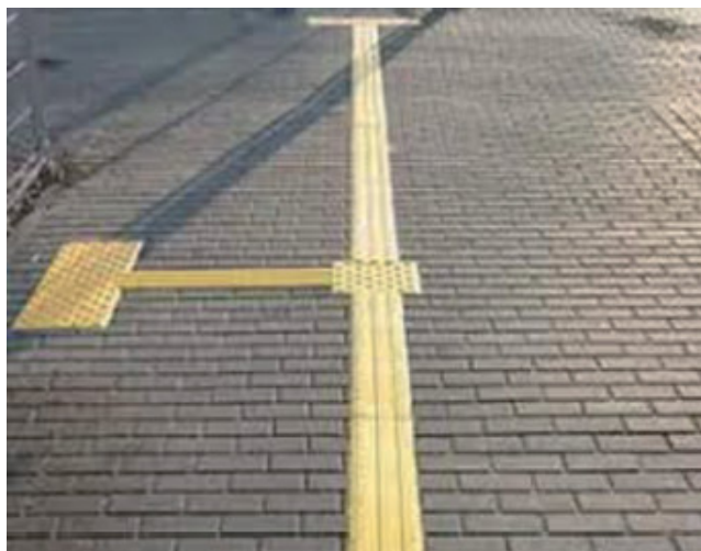
Fot. 1. Przykład zastosowania pasów informacyjno-prowadzących oraz pola uwagi w posadzce - elementy betonowe [8]
