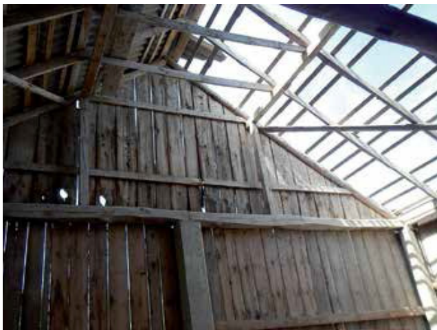
Fot. 7. Dachy nad wiatami, stodołami i magazynami z otwartymi wrotami nazywane są dachami otwartymi. Wiatr działa na nie odwrotnie i wywiera ciśnienie od środka wpadając przez wrota lub konstrukcję bez litych ścian.
