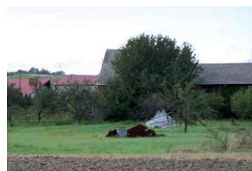
Fot. 3. Te fragmenty dachu zostały przeniesione na odległość 250 m. Zdjęcie zostało zrobione z krawędzi budynku, z którego „sfrunął” ten dach. Tutaj też widać łaty i kontrłaty przeniesione na „skrzydło” blach. Ten efekt zgadza się z działaniem pokazanym na schemacie z rys. 2.
