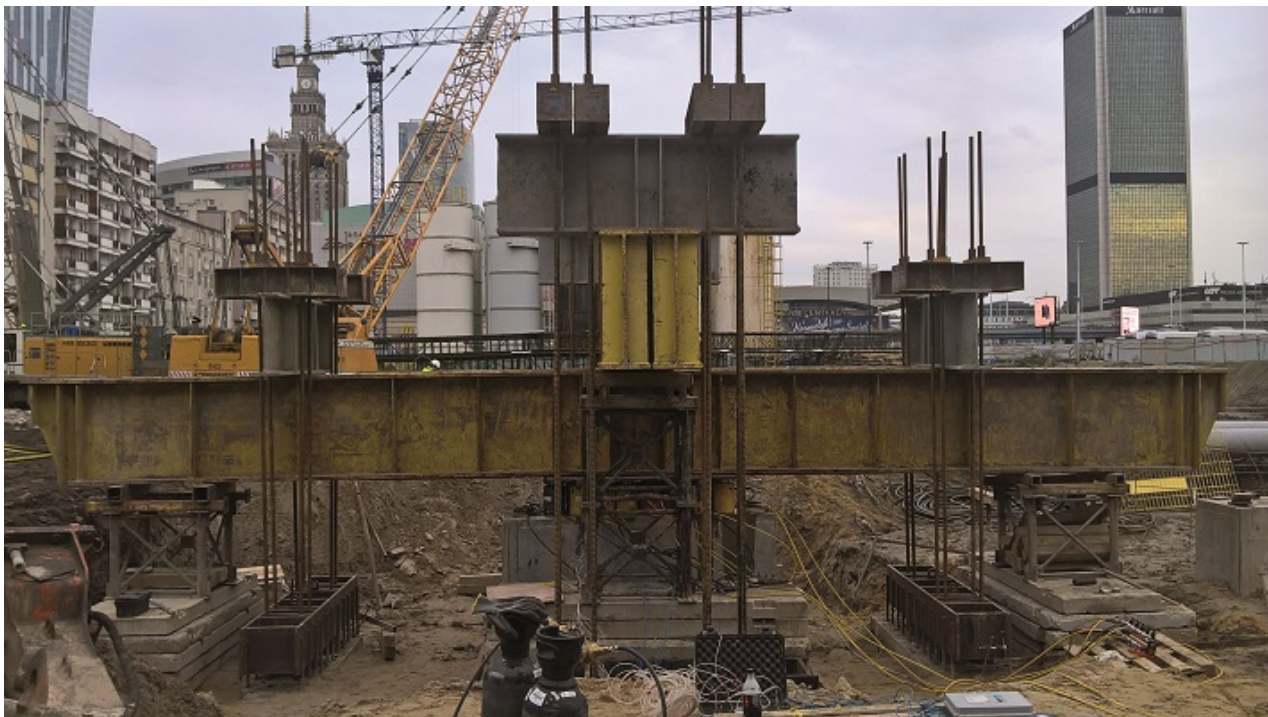
Fot. 1. Widok konstrukcji badanej baretę (fot. autora)
