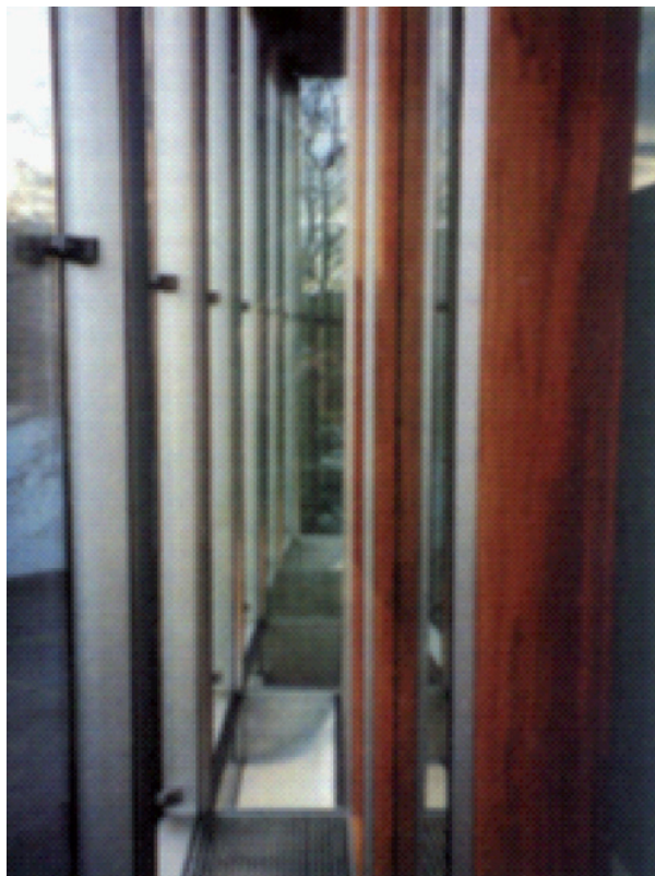
Fot. 3. Budowa ściany dwupowłokowej
