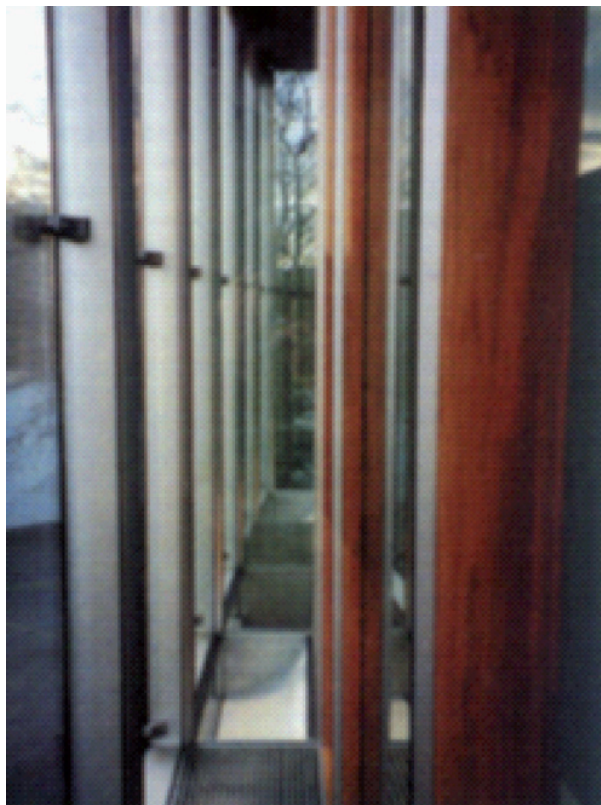
Fot. 3. Budowa ściany dwupowłokowej
